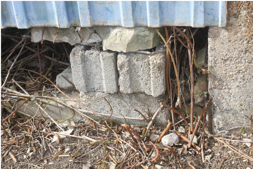
Abb. 2: Fugenreiche Mauer aus Beton – potentielle Versteckmöglichkeit für Reptilien
